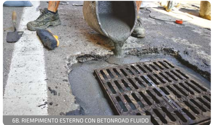
6B. RIEMPIMENTO ESTERNO CON BETONROAD FLUIDO
