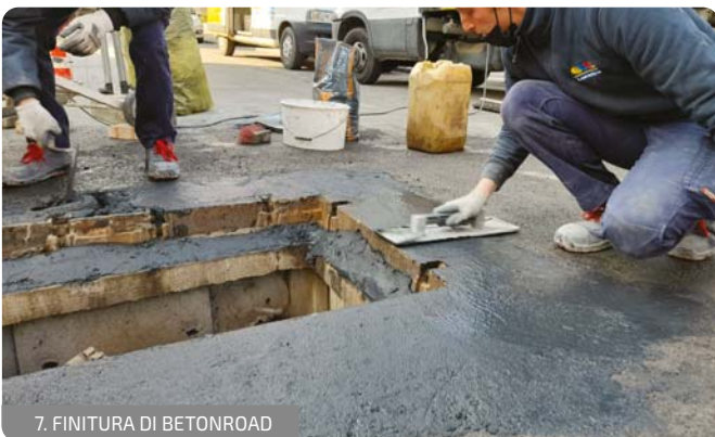
7. FINITURA DI BETONROAD
