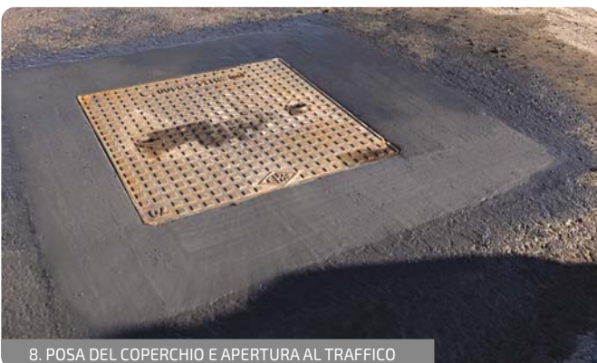
8. POSA DEL COPERCHIO E APERTURA AL TRAFFICO
