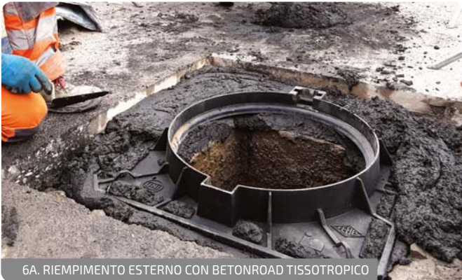
6A. RIEMPIMENTO ESTERNO CON BETONROAD TISSOTROPICO
