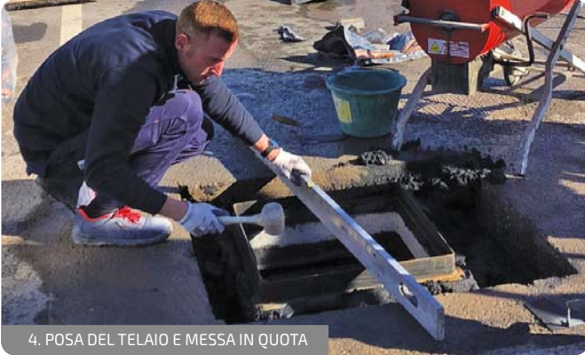
4. POSA DEL TELAIO E MESSA IN QUOTA
