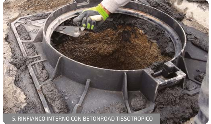
5. RINFIANCO INTERNO CON BETONROAD TISSOTROPICO
