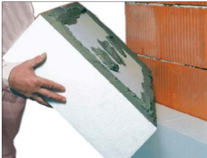
Fissaggio delle lastre SIRAPOR 100 mediante malta adesiva.
