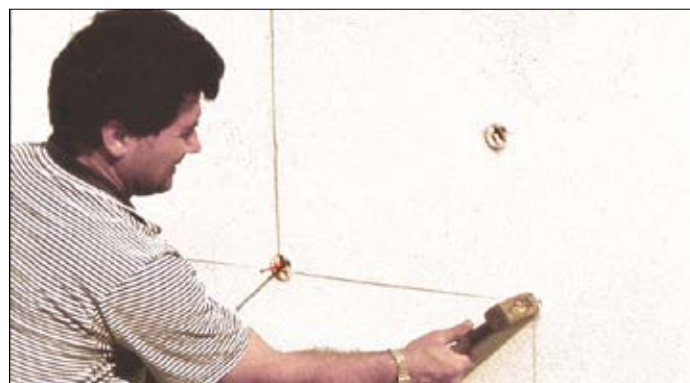
Fissaggio meccanico con chiodi in pvc ad espansione.
