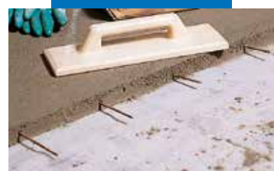
Particolare di massetto in Topcem con ferri di ripresa di getto
