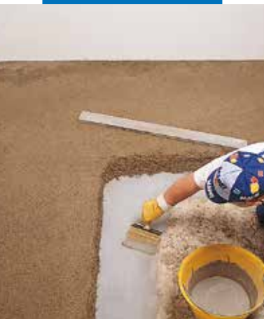
Stesura della boiaccia di ancoraggio per massetti aderenti in Topcem
