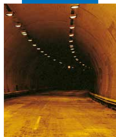
Applicazione a spruzzo di Planiseal 88 bianco in galleria autostradale
