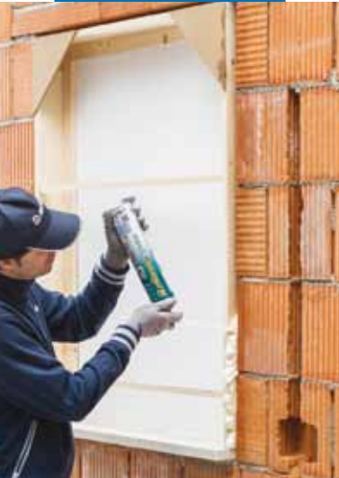
Riempimento tra telaio di serramento e muro
