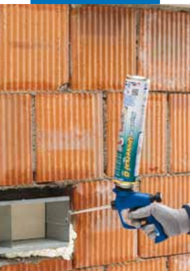
Riempimento di canale di ventilazione
