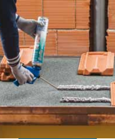
Incollaggio a cordoli di tegole
