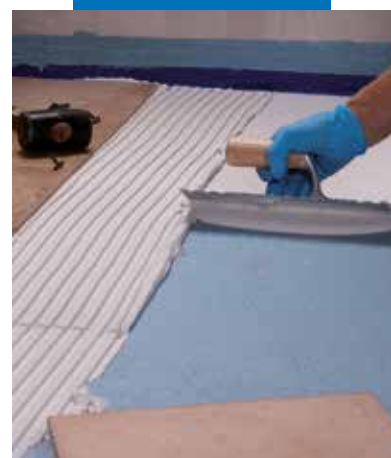
Incollaggio delle piastrelle su Mapelastic AquaDefense
