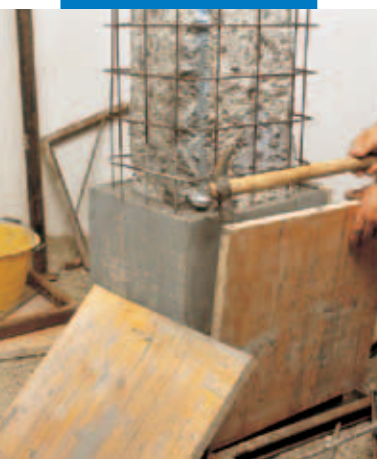
Disarmo da cassero in legno
