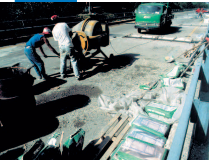
Rifacimento di giunti stradali
