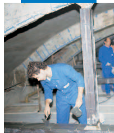
Getto con Mapegrout Colabile in cassero metallico
