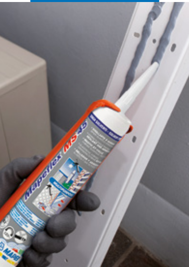
Incollaggio di profili in plastica in esterno
