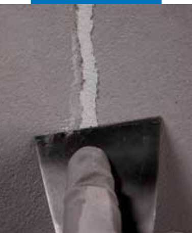
Lisciatura superficiale con spatola
