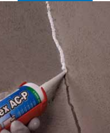
Estrusione di Mapeflex AC-P nel giunto
