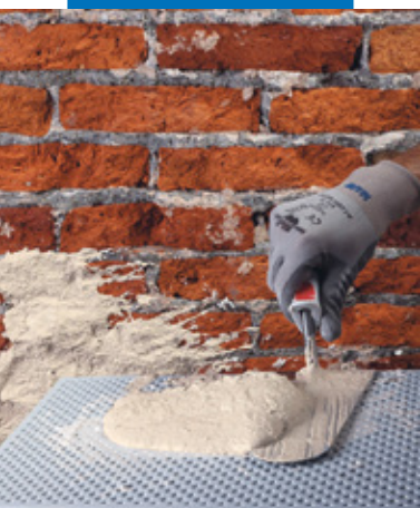
Applicazione di Mape-Antique Eco Rinzafo su supporto in mattone pieno
