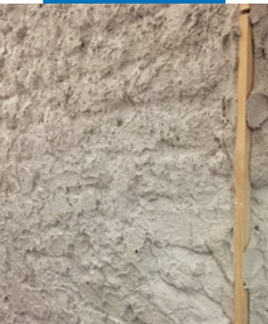
Applicazione a "poro chiuso" di Mape-Antique Eco Rinzafo
