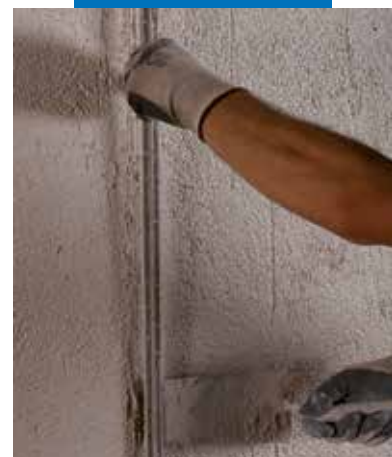
Rimozione della guida verticale
