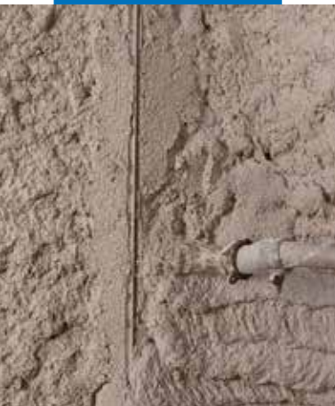
Applicazione di Mape-Antique MC Macchina
