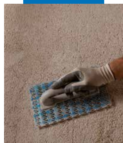
"Rabottatura" di Mape-Antique MC Macchina
