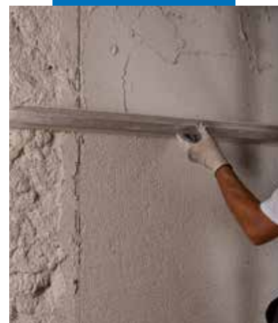
Staggiatura di Mape-Antique MC Macchina
