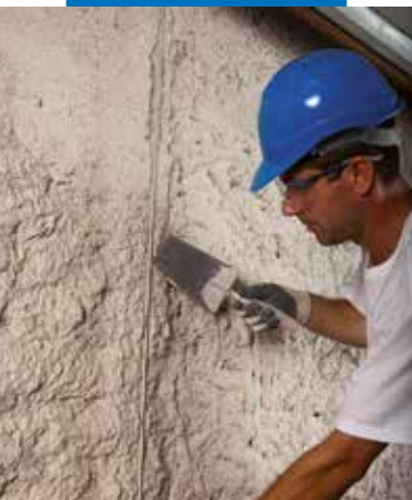
Posizionamento di una guida verticale
