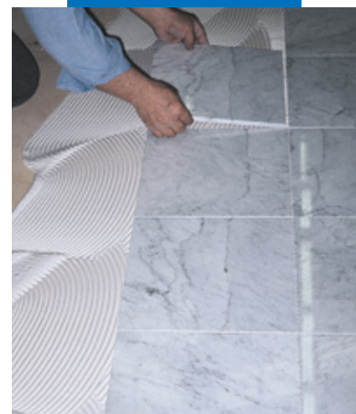
Posa di marmo di Carrara su supporto in legno con Keralastic bianco
