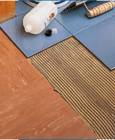
Posa su vecchi pavimenti in PVC
