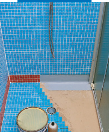
Impermeabilizzazione e posa in box-doccia prefabbricato
