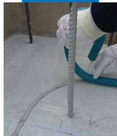
Applicazione di Idrostop Soft su superfici orizzontali
