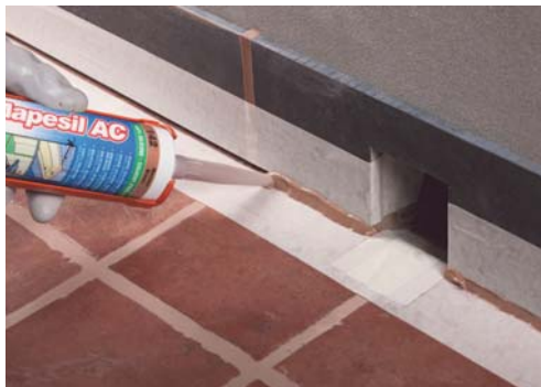
13. Sigillare con Mapefil AC in corrispondenza del raccordo zoccolino-pavimento e zoccolino-parete
