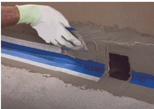
8. Posare Mapeband, esercitando una leggera pressione sui lati e facendo attenzione a non creare delle grinze e a non inglobare delle bolle d'aria
