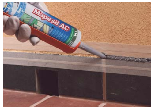
13. Sigillare con Mapefil AC in corrispondenza del raccordo zoccolino-pavimento e zoccolino-parete
