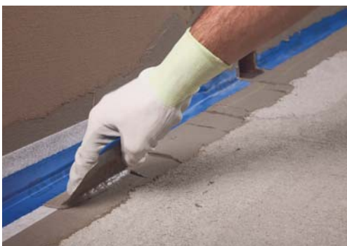
9. Stendere un secondo strato, fresco su fresco, del prodotto impermeabilizzante MAPEI, coprendo completamente le parti laterali del nastro con il nuovo strato, inglobando i lati della bandella all'interno dei due strati di impermeabilizzante
