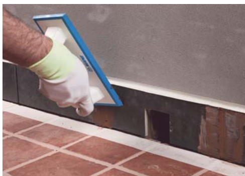
12. Incollare lo zoccolino e stuccarne le fughe verticali
